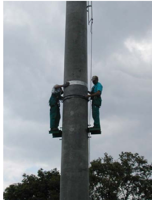
12. A kinyomódott ragasztóhabarcsot letörölni, a takarógyűrűt a helyére igazítani., a tartókötelet levenni
