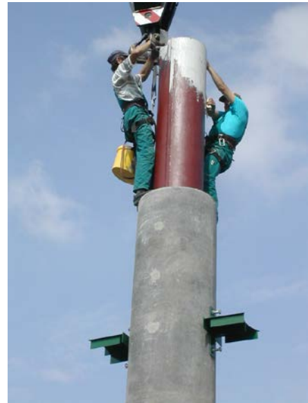
8. A StoPox SK 41 ragasztóanyagot bekeverni az utasítás szerint, az acélcsővet és a felső tag belsejét bekenni
