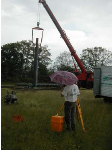
5. Az oszlop függőbe állítása két irányból a menetes szárazon levő anyákkal, beállítás után keményfa ékkel biztosítani
