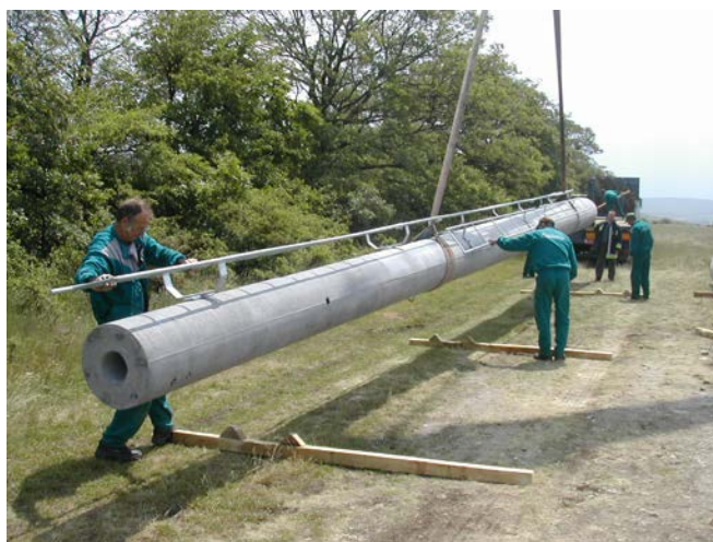
2. Oszlopok leemelése, alátétfákra helyezése, (amennyiben szükséges, szerelvények felszerelése az oszlopokra)
