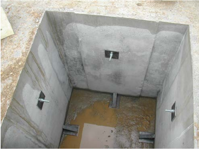
1. Alaptest elkészítése, központosító ékek bemérése, levágása, menetes szárok elhelyezése az előre elkészített üregekbe a kehelyfalakban
