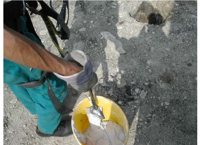
8. A StoPox SK 41 ragasztóanyagot bekeverni az utasítás szerint, az acélcsővet és a felső tag belsejét bekenni
