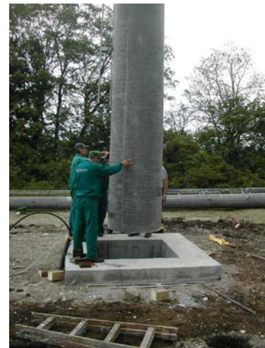
3. Oszlop emelése hurkolt kötéllel, biztosító csappal
