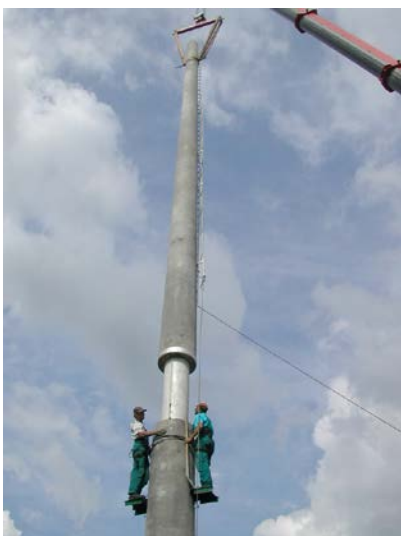
11. A felső tag emelése hurkolt kötéllel, biztosító csappal, mielőtt a ragasztóanyag megköt. A felső tag aljára kötött kötéllel segíteni lehet iránytartását a földről
