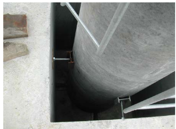
4. Az oszlop beállítása a kehelyalapba, a menetes szárok alá I szelvény elhelyezése (25-30 cm) a nagyobb felfekvés miatt
