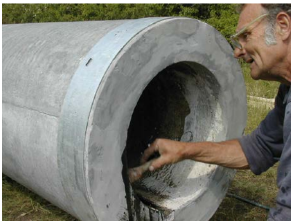
7. A beton szilárdulása után (másnap) a StoPox IHS BV kétkomponensű alapozóval a felső tagot belülről bekenni (keverési utasítás szerint)
