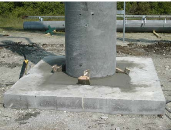
6. Betonozás vibrálással, az oszloptól enyhe lejtéssel lesimítás
