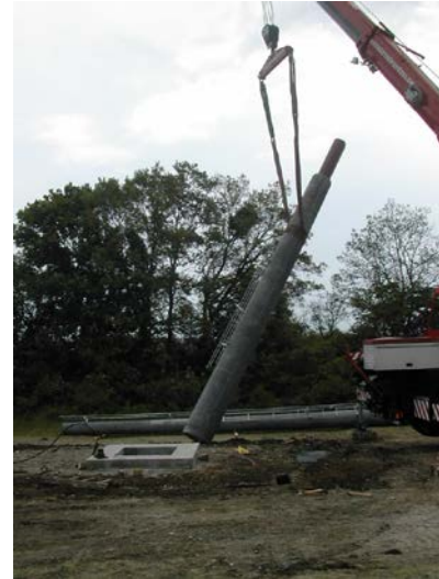
3. Oszlop emelése hurkolt kötéllel, biztosító csappal
